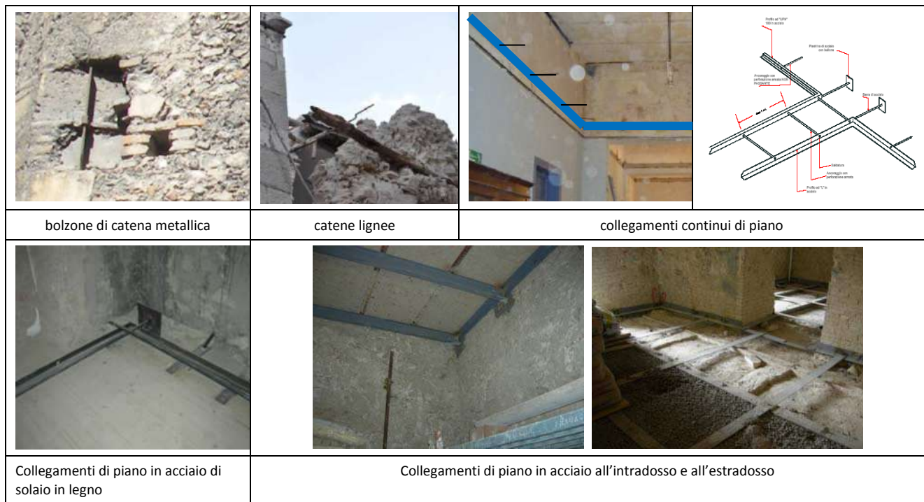
Fig. 48 – collegamenti di piano
