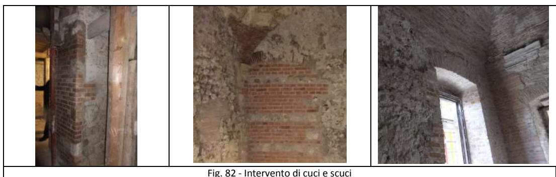
Fig. 81 – interventi di tipo A : riparazione del danno e regolarizzazione del paramento murario : sarcitura lesioni, cucì scuci, stilatura, stuccatura profonda, intonaco, ... .
