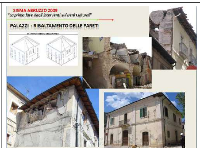
Fig. 49 - ribaltamento delle pareti
