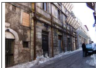
Fig. 1 Aggregato urbano nel centro storico di L'Aquila
