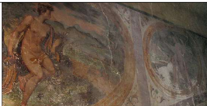
Fig. 183 - Foto degli affreschi, presenti all'interno del edificio, danneggiati dal sisma del 2009
