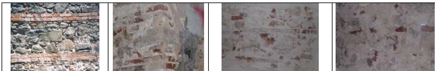
Fig. 78.2 – riconoscimenti tipologico muratura di classe A e interventi possibili
