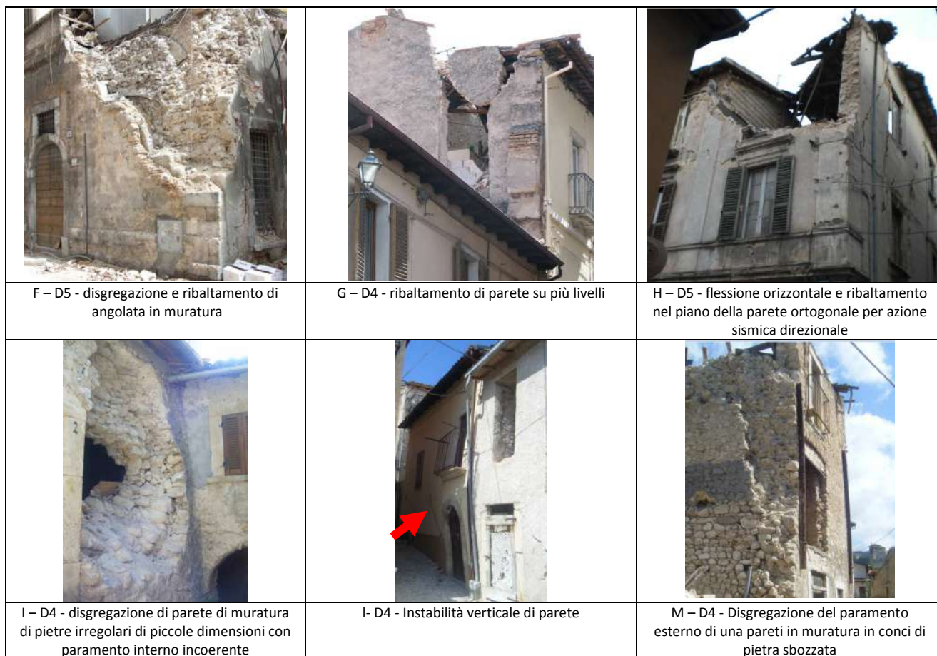
Fig. 92 – analisi del danno in relazione ai meccanismi attivati
