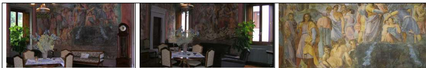
Fig. 134 - Affreschi di edificio vincolato prima del 6 aprile 2009
